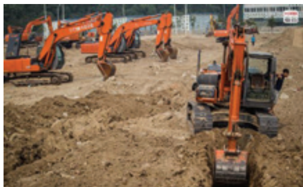
学员上挖掘机练习
