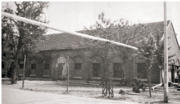
山东机器局旧址
